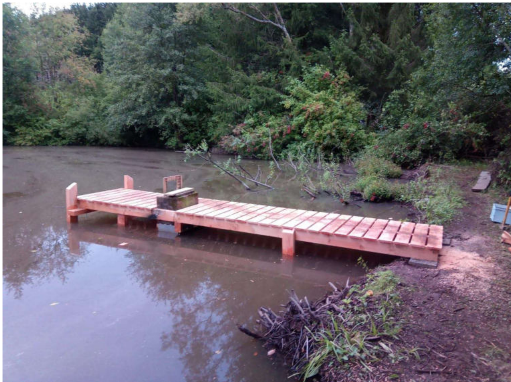
Neuer Steg mit Entwässerungsrohren
