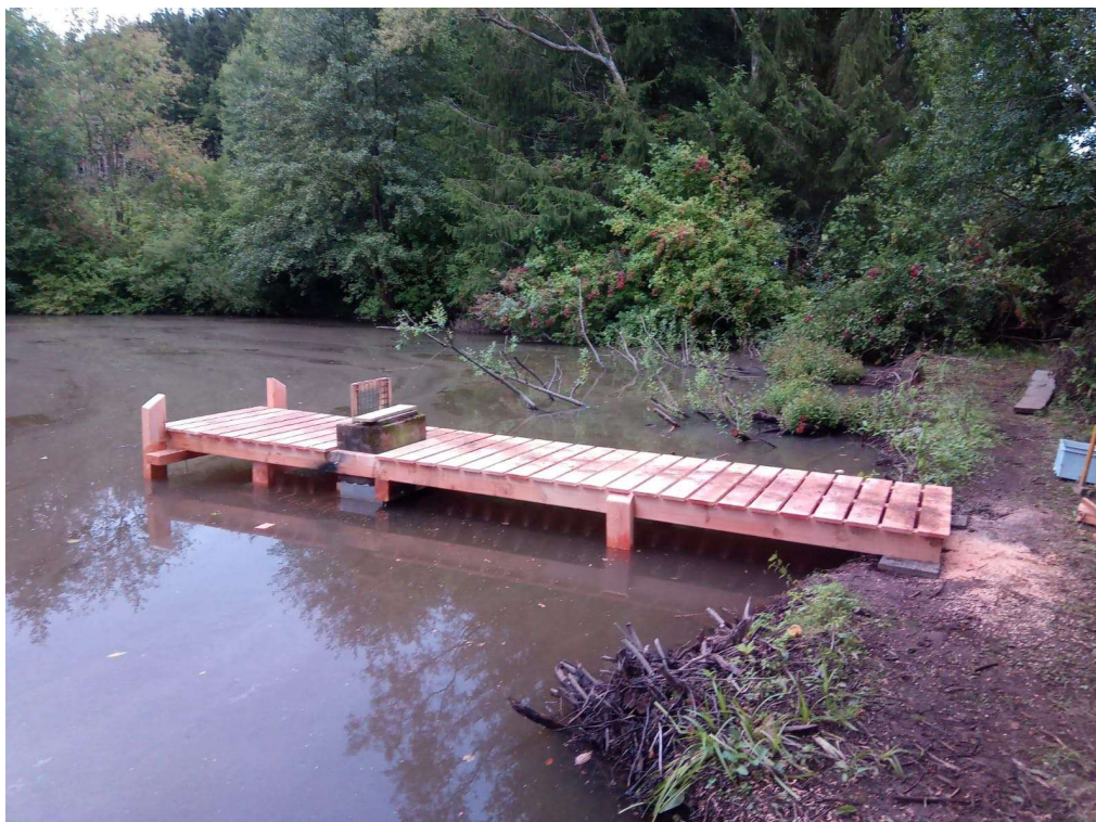
Neuer Steg mit Entwässerungsrohren
